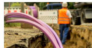
12 až 14 barů: Vrtání a protlak kabelů
