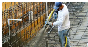
7 až 12 bar: Aplikace stříkání betonu
